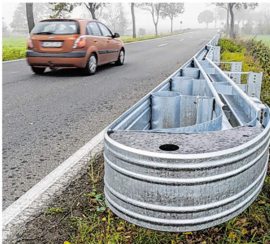
Leitplanken, neue Fahrbahnmarkierungen, das Tempo-70-Limit und Baumfällungen sollen weitere Unfälle auf der L 327 verhindern. Foto: wel
